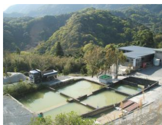
汚濁水を排出しない 為沈殿池の維持管理
