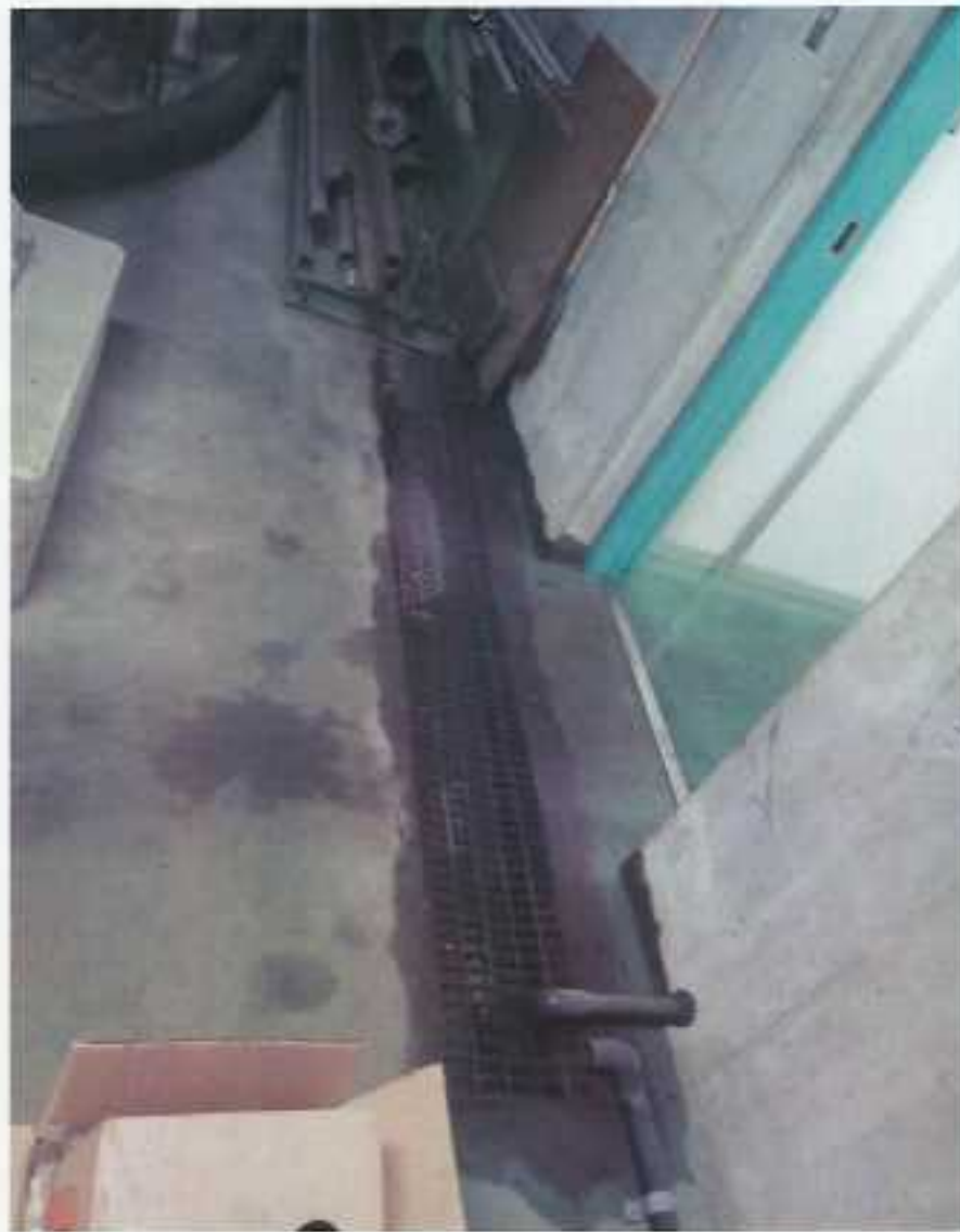
写真④ 工場棟内 側溝部
