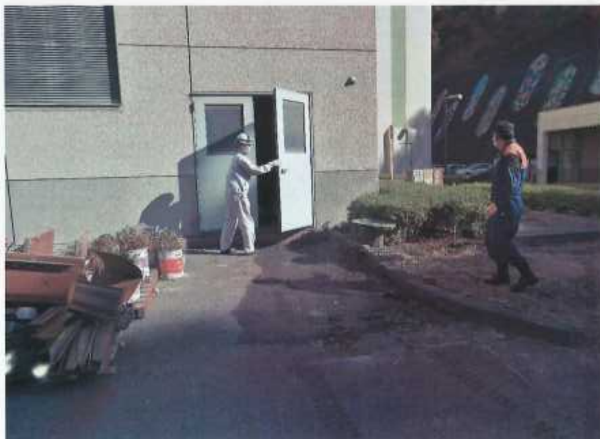
写真⑥ ポンプ室外
