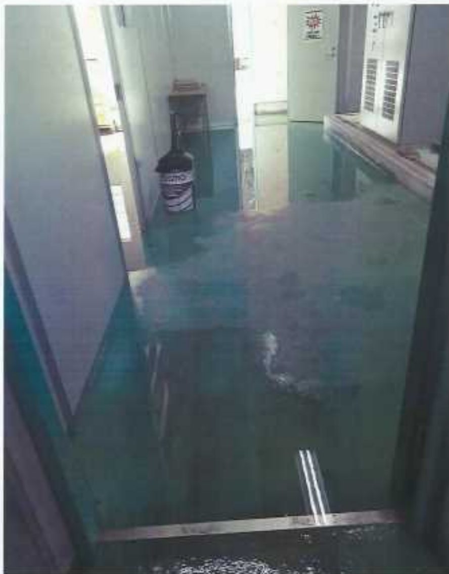
写真③ 誘引通風機室
